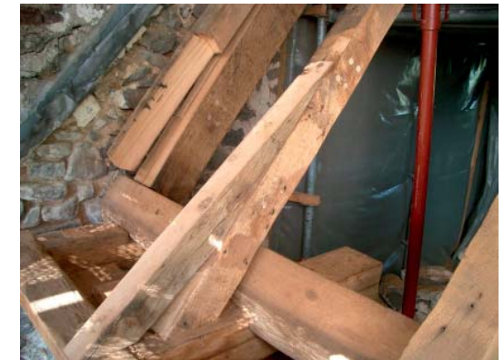
Reparatur Sparrenfuß mit Eichenholz aus Zweitverwendung Foto: Jürgen Knöss
